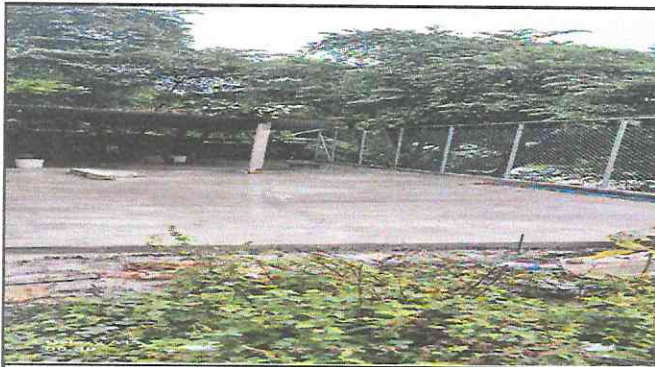
Foto 3: Fundicion de torta de cemento
