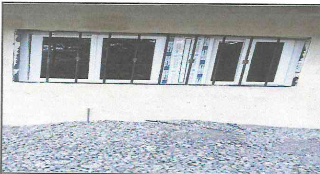
Foto 5: Colocacion de ventanas
