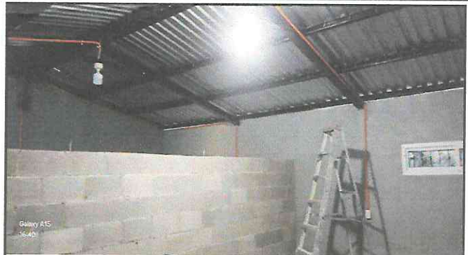
Foto 2: Instalacion de energia electrica
