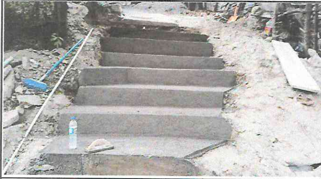
Foto 1: Terminacion de gradas
